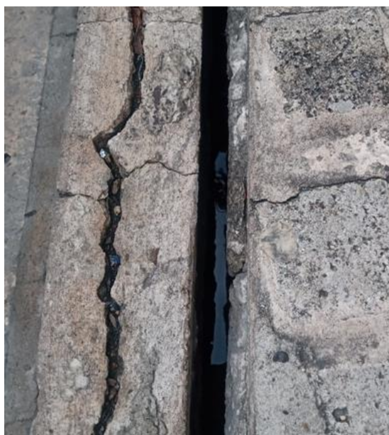
Foto 1. Desplazamiento lateral - viga confinamiento pavimento parqueaderos
