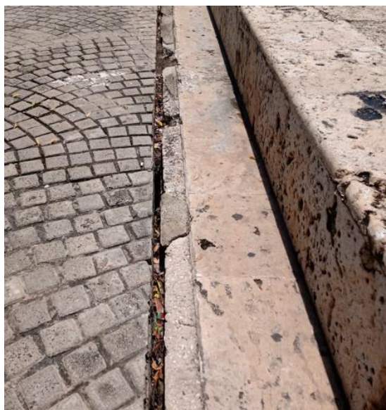
Foto 2. Hundimiento Viga de confinamiento pavimentos parqueaderos
