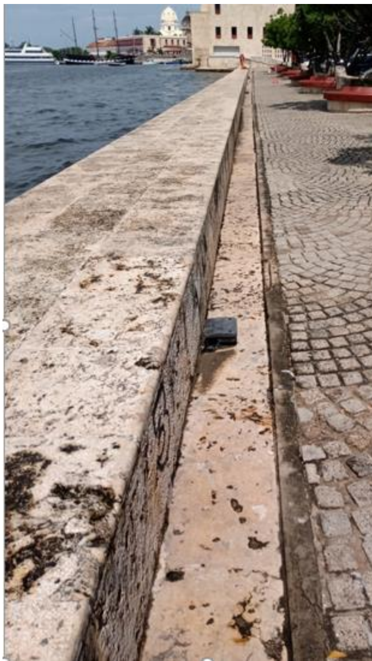
Foto 3. Hundimiento y desplazamiento lateral viga de confinamiento parqueaderos.
