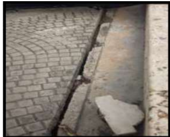
Figure 24. Agrietamiento paralelo a la estructura evidente en el parqueadero
