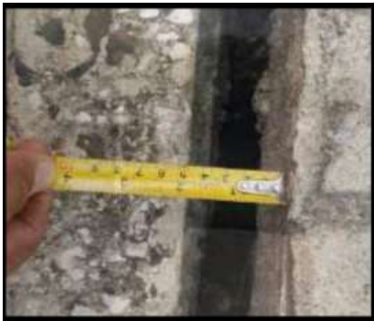
Figure 24. Agrietamiento paralelo a la estructura evidente en el parqueadero
