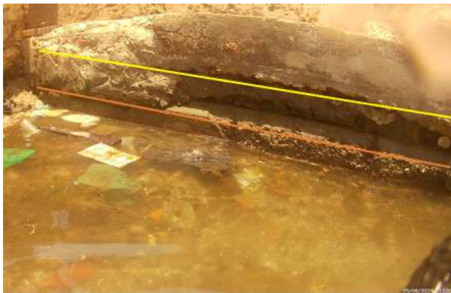
Figure 13. FOTO METRO 1,10 M DE LOS 847 M resaltando la exposición de hierros, corrosión y desprendimientos
