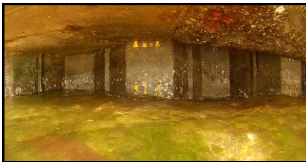
Ilustración N°7. Zona de tablestacado metálico instalado por la empresa BUZCA S.A.
