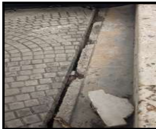
Ilustración N°13. Separación del hormigón de 4 y 5 centímetros.
