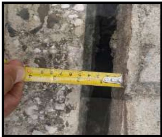
Ilustración N°13. Separación del hormigón de 4 y 5 centímetros.
