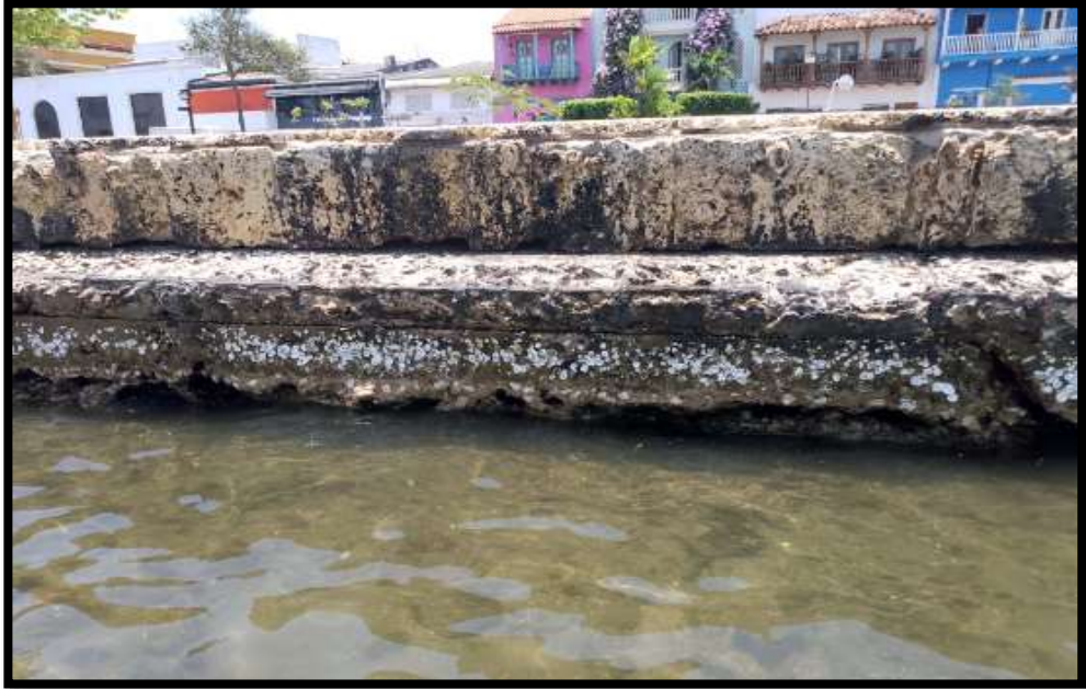
FOTO METRO 688 M DE LOS 847 M
