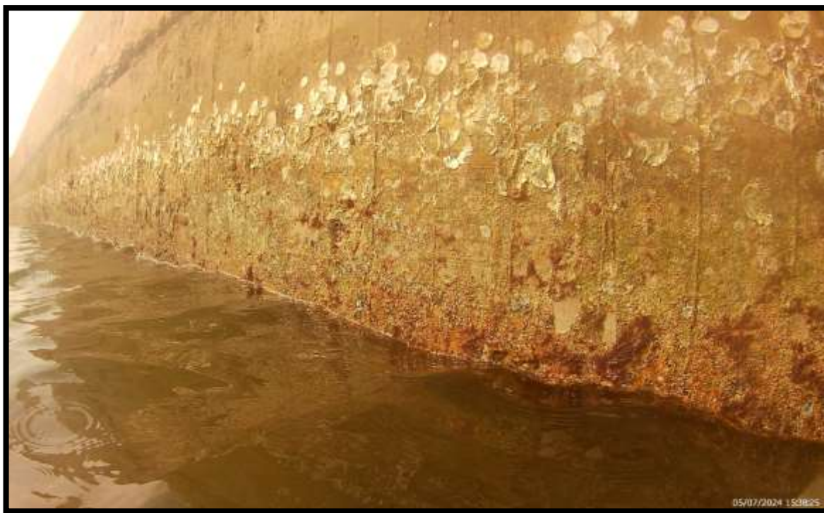
FOTO METRO 75 M DE LOS 847 M
