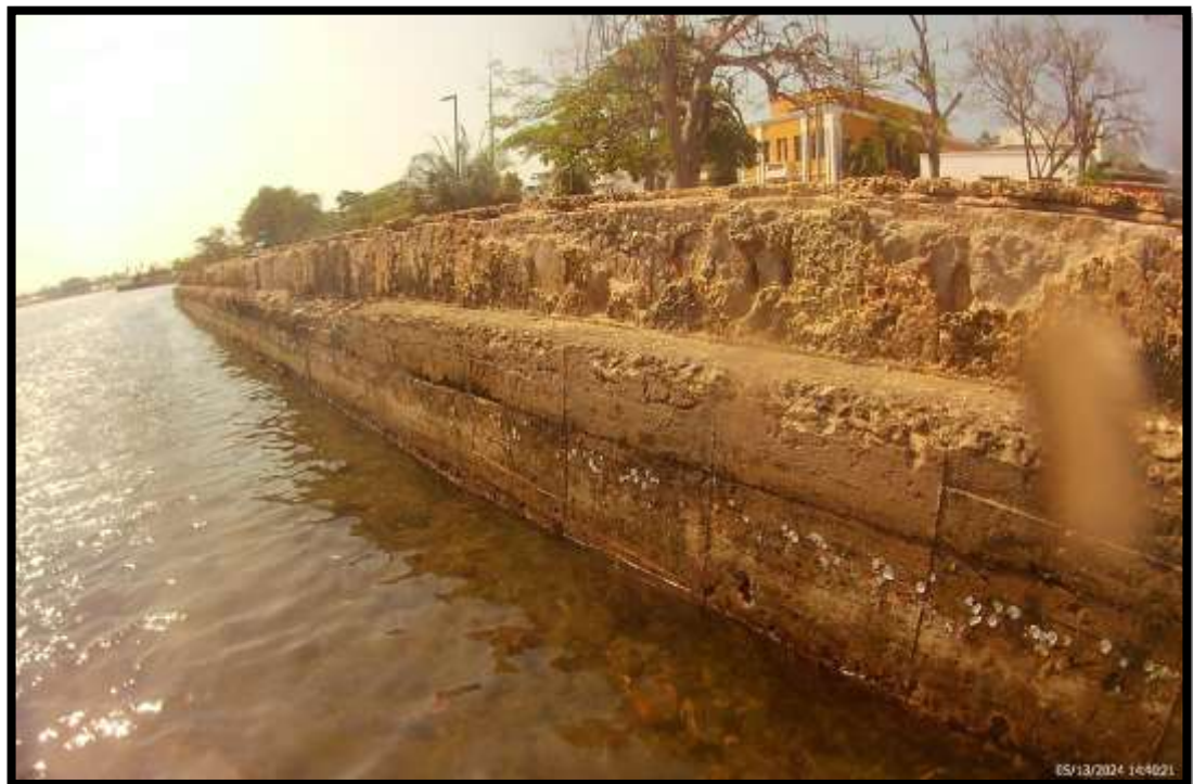
FOTO METRO 680 M DE LOS 847 M
