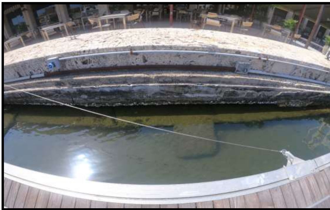
FOTO METRO 137 M DE LOS 847 M
