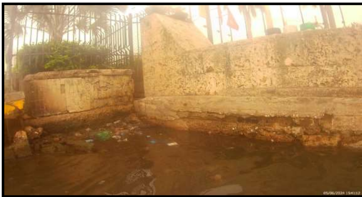
FOTO METRO 02 M DE LOS 847 M
