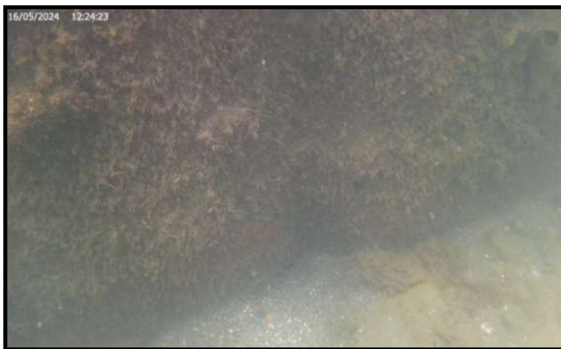
FOTO METRO 840 M DE LOS 847 M
