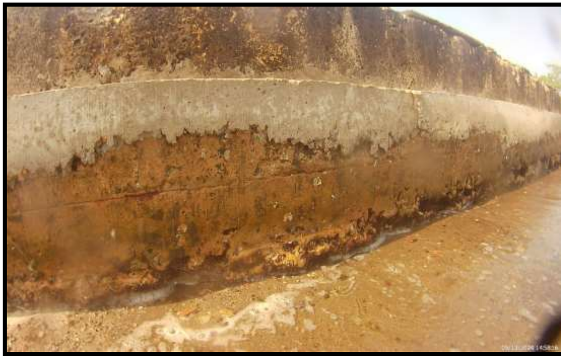
FOTO METRO 560 M DE LOS 847 M
