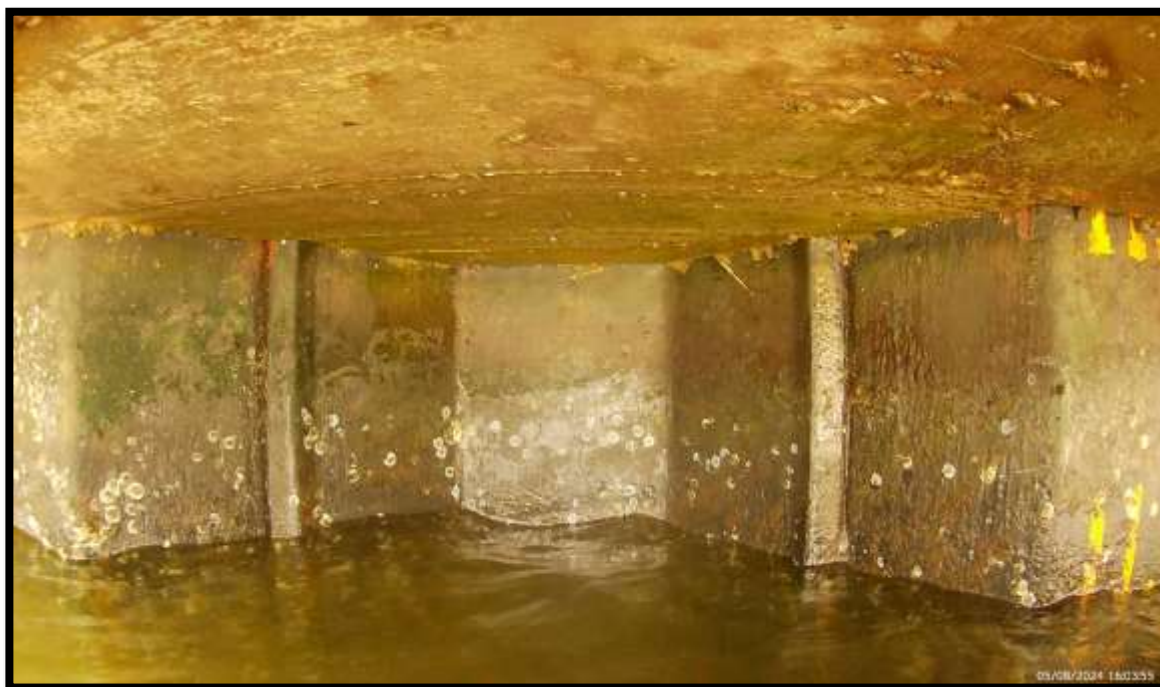
FOTO METRO 114 M DE LOS 847 M
