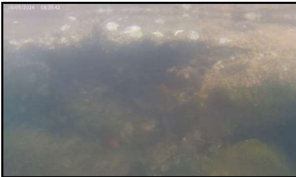
FOTO METRO 70 M DE LOS 847 M
