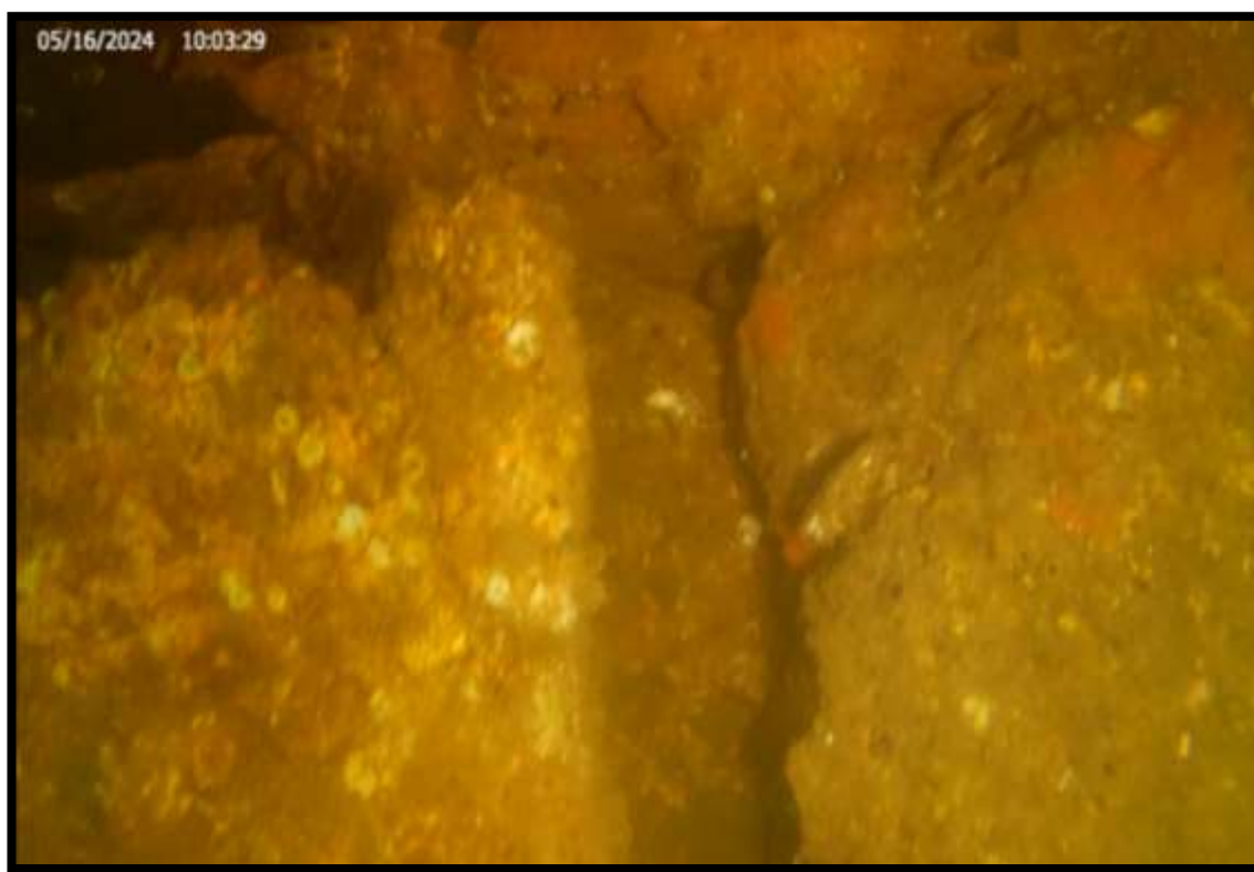
FOTO METRO 255 M DE LOS 847 M
