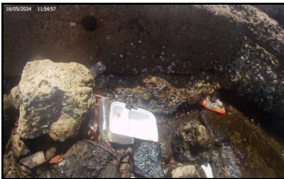
FOTO METRO 472 M DE LOS 847 M
