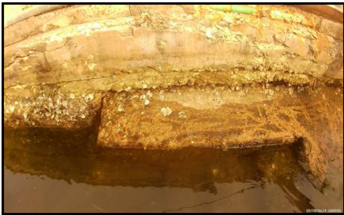
FOTO METRO 163 M DE LOS 847 M
