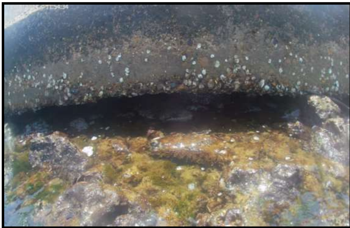
FOTO METRO 461 M DE LOS 847 M
