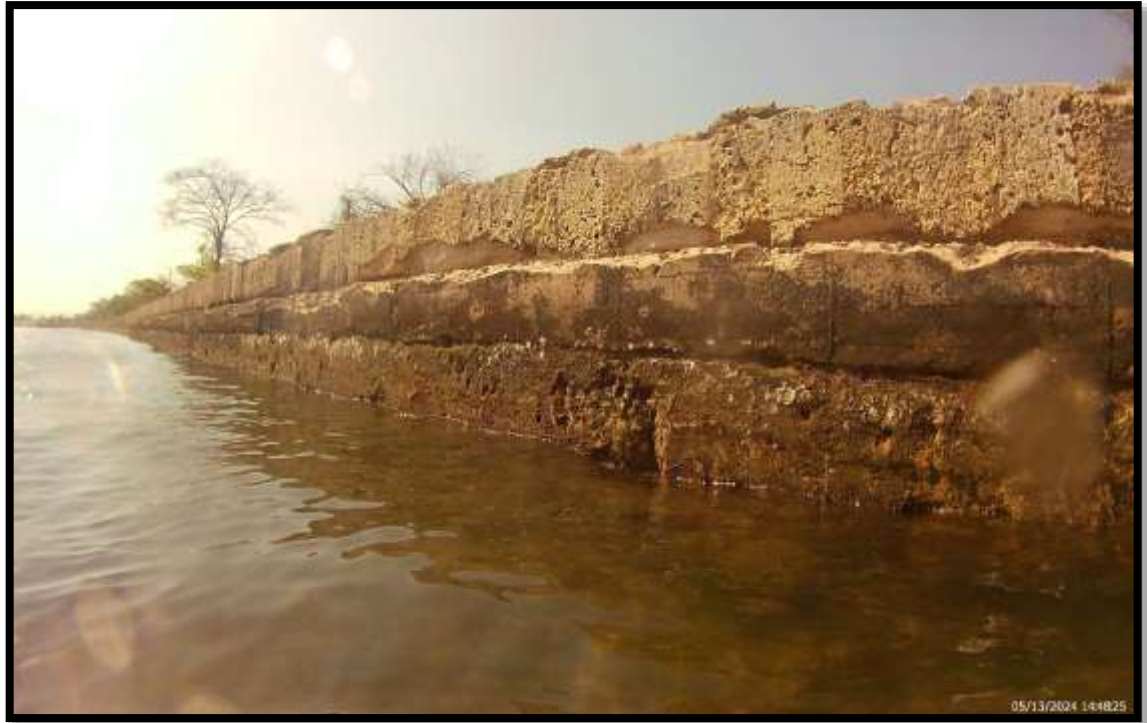
FOTO METRO 661 M DE LOS 847 M
