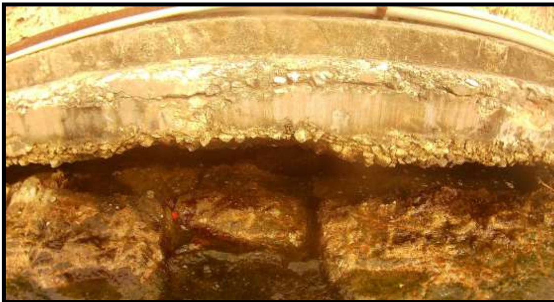
FOTO METRO 135 M DE LOS 847 M
