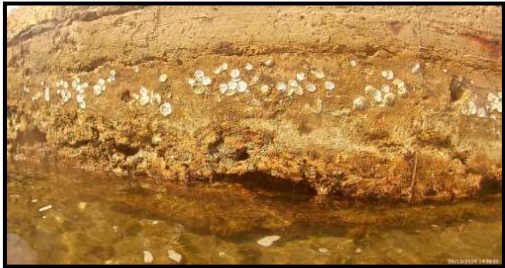
FOTO METRO 721 M DE LOS 847 M
