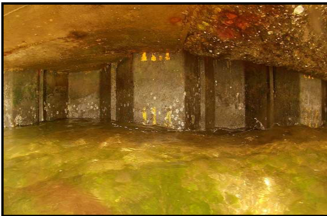
FOTO METRO 110 M DE LOS 847 M
