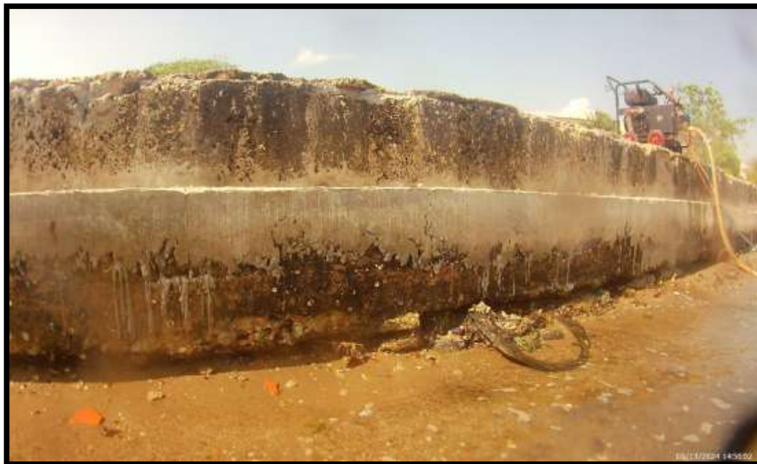
FOTO METRO 621 M DE LOS 847 M
