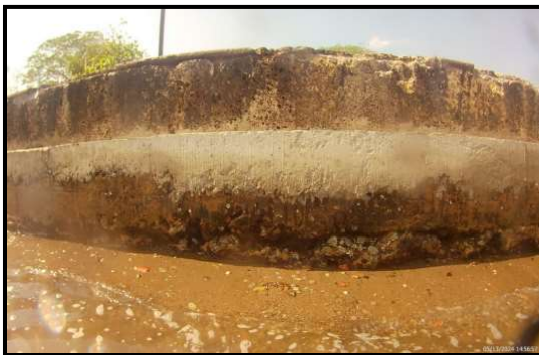
FOTO METRO 606 M DE LOS 847 M
