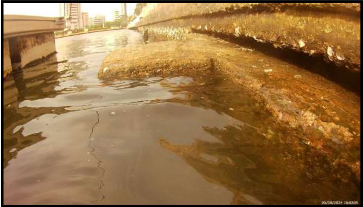
FOTO METRO 131 M DE LOS 847 M
