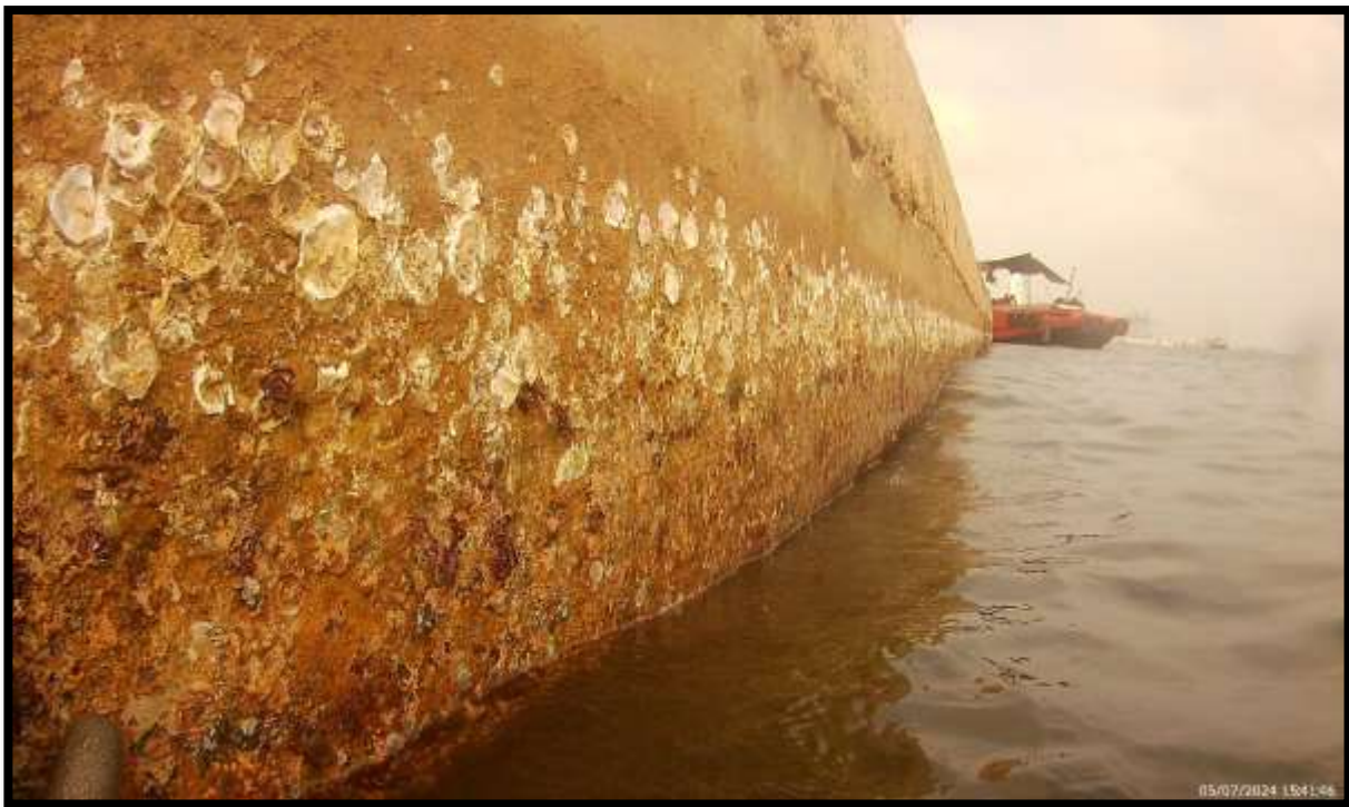
FOTO METRO 352 M DE LOS 847 M
