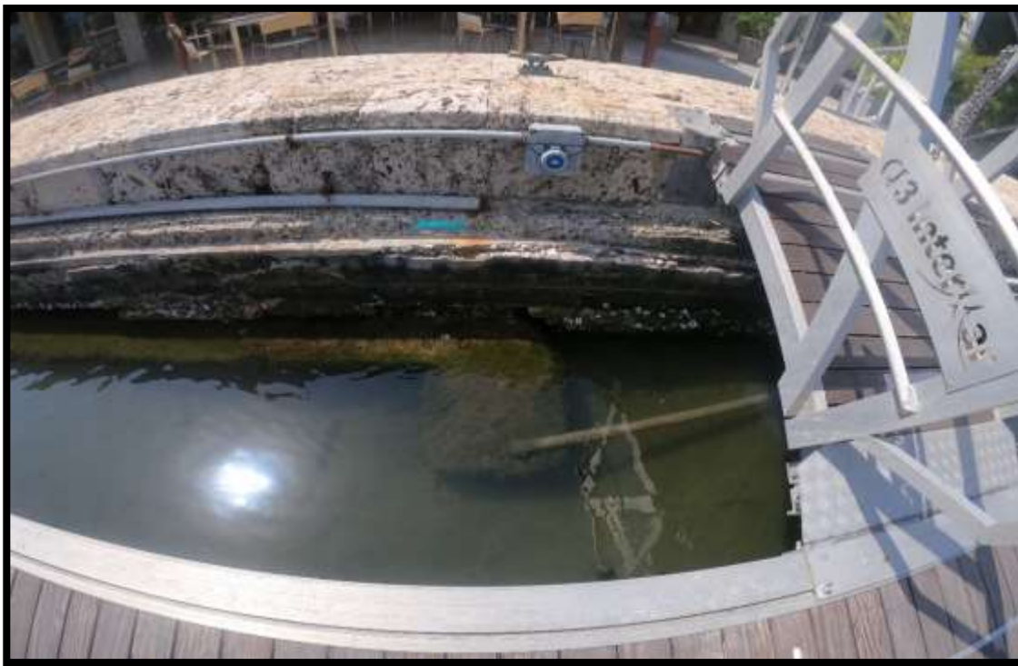
FOTO METRO 138 M DE LOS 847 M
