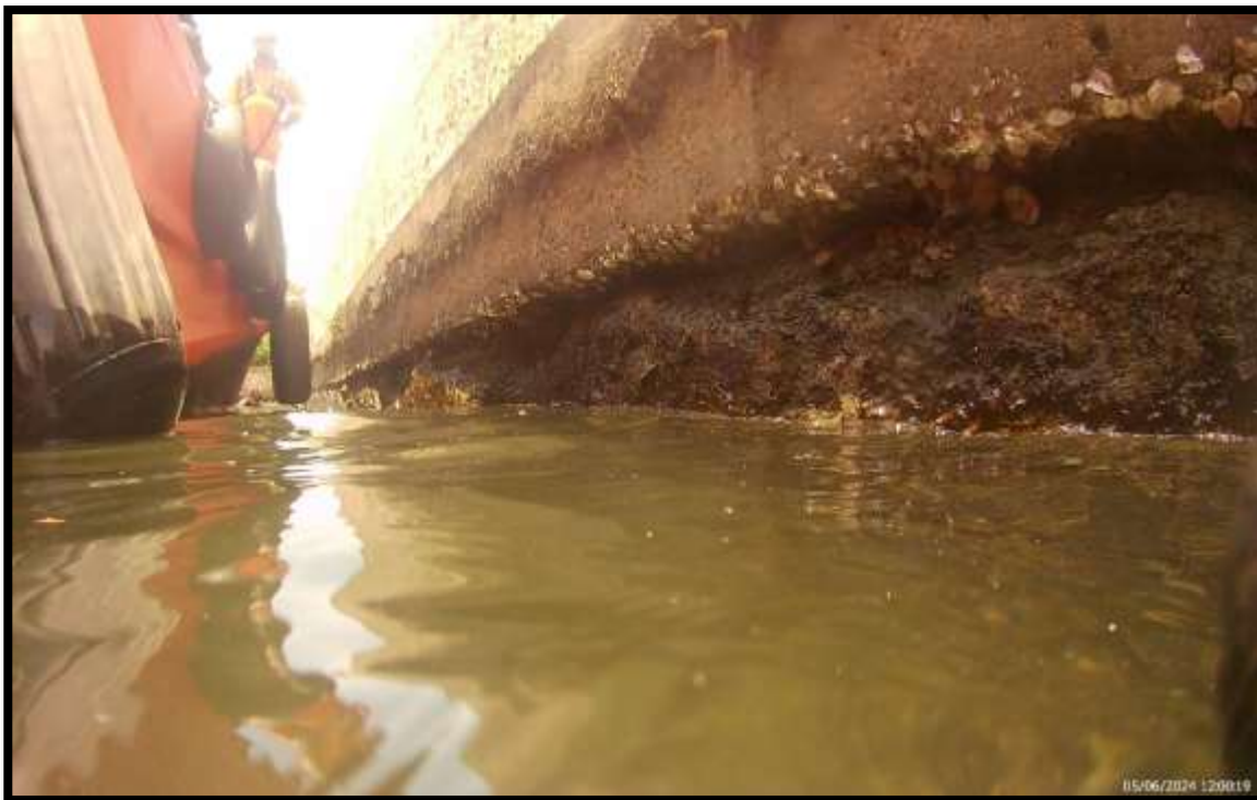
FOTO METRO 50 M DE LOS 847 M.
