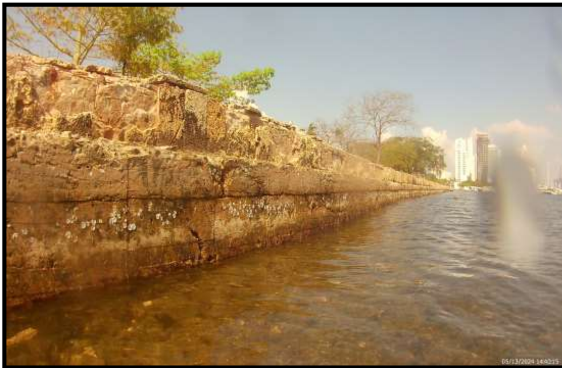
FOTO METRO 686 M DE LOS 847 M
