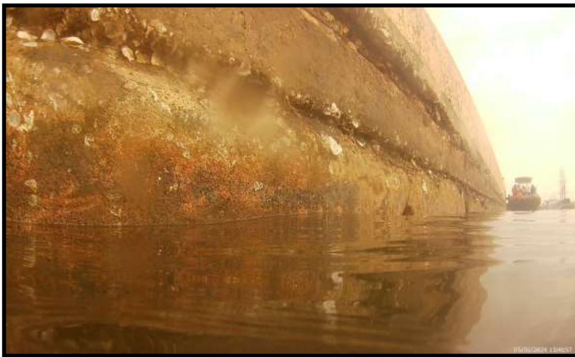
FOTO METRO 23 M DE LOS 847 M
