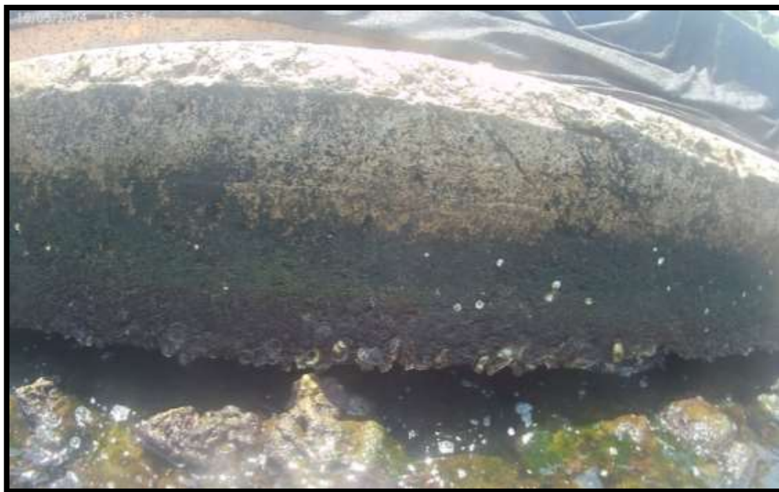
FOTO METRO 456 M DE LOS 847 M
