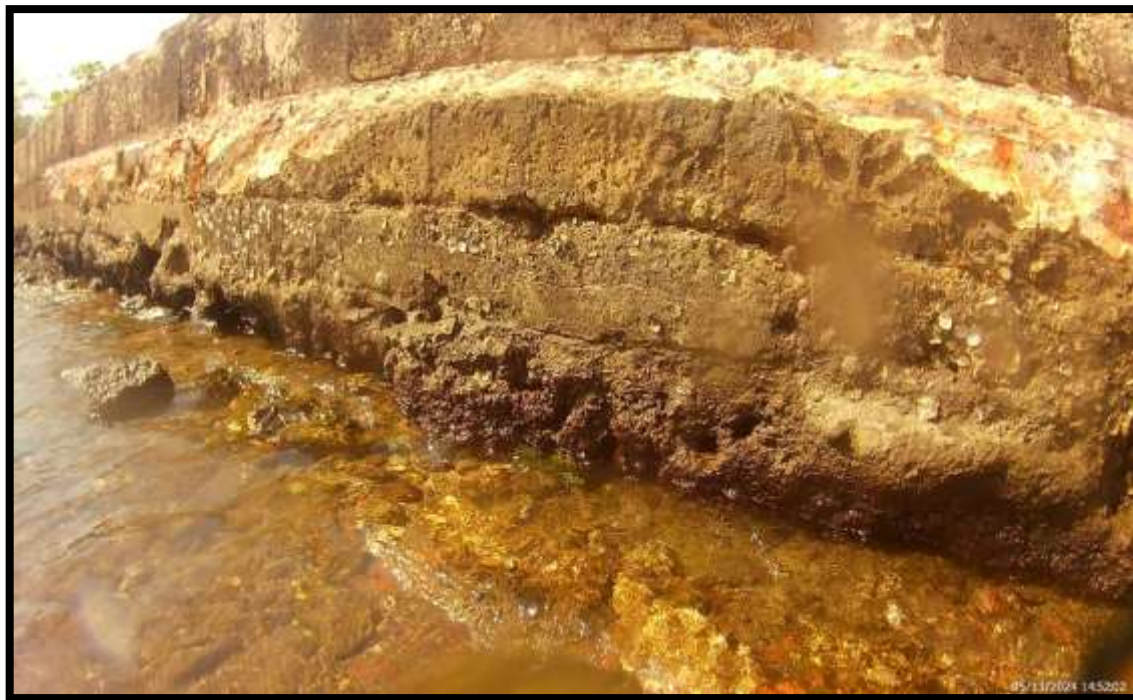
FOTO METRO 638 M DE LOS 847 M
