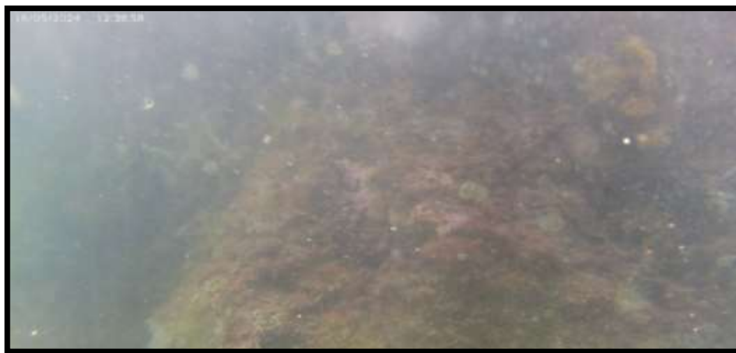
FOTO METRO 807 M DE LOS 847 M
