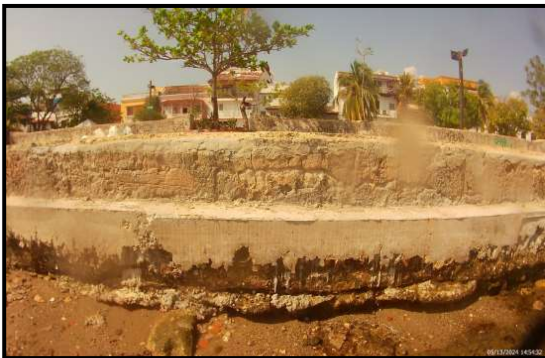
FOTO METRO 635 M DE LOS 847 M
